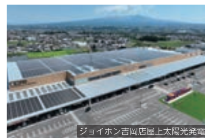
ジョイホン吉岡店屋上太陽光発電
