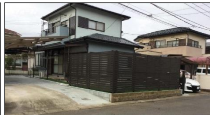
動画画像（施工後）
