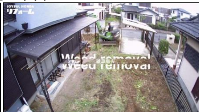
動画画像（施工中）
