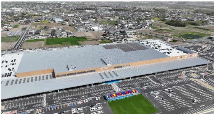
▲ 太陽光パネル（1期工事時点、最終的には屋根全体に設置予定）
