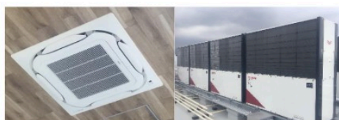
▲ ガスエンジンと電気モーターの原動機を搭載するハイブリッド空調機
