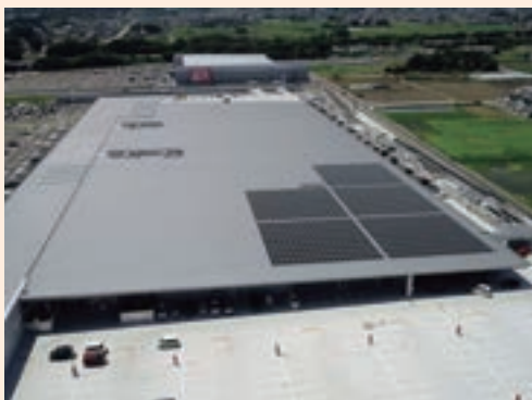
▲太陽光パネル（1期工事時点、最終的には屋根全体に設置予定）
